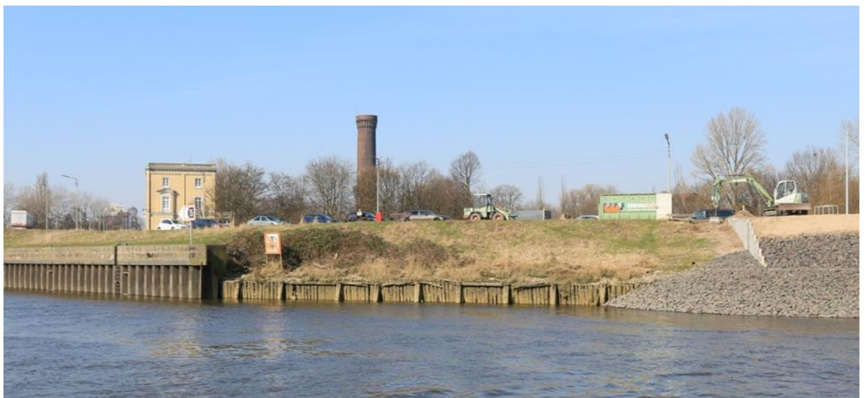
Verschiedenartige Uferbefestigungen im Hamburger Hafen (Foto: Stiftung Lebensraum Elbe)
