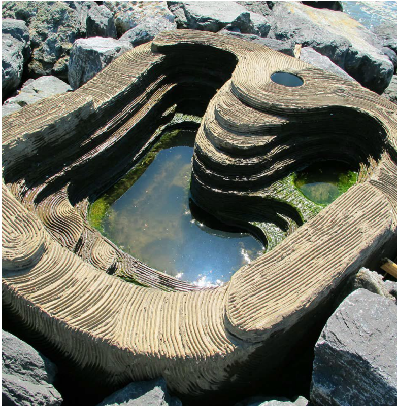
Abb. 4: „Tide Pools“, die aktuell von HPA versuchsweise in einer Uferböschung eingebaut werden, s. Text Quelle: HPA, Frau Matheuszik; EConcrete®
