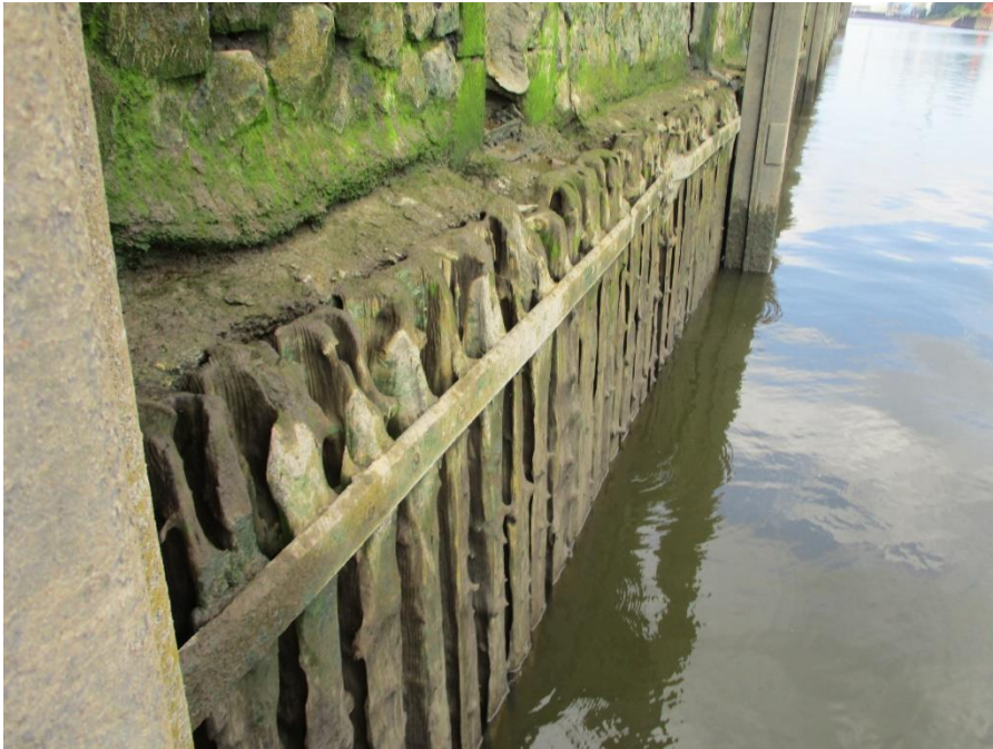
Abb. 8: Ältere Holzvorsetze im Bremer Holzhafen, die das entstehende Lückensystem veranschaulicht Foto: BioConsult
