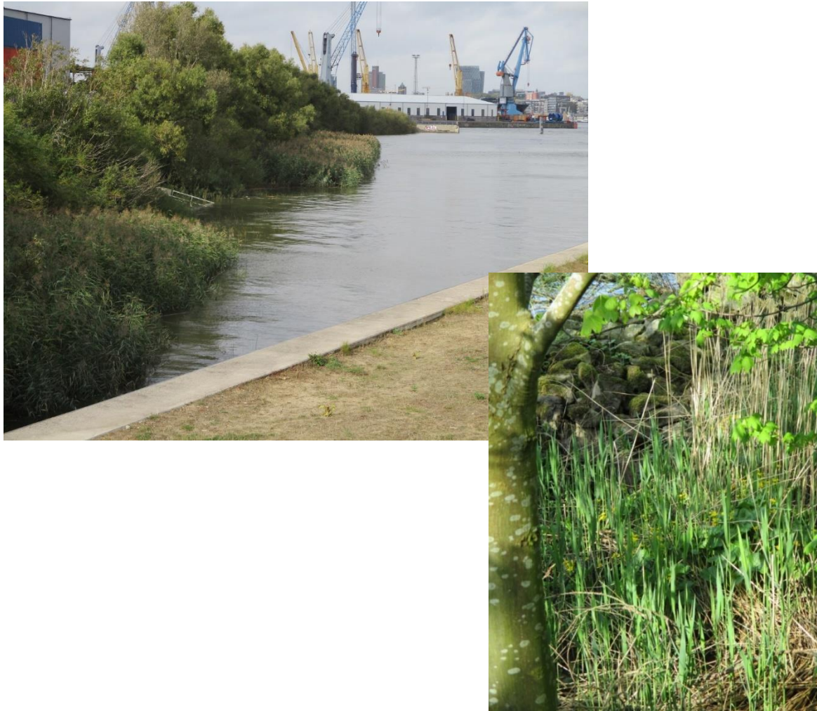
Abb. 10: Links: Pflanztasche mit Weidenstreifen und vorgelagertem Röhrichtgürtel im Hamburger Hafen (äußerer Hansahafen). Rechts: Beispiel der Vegetation in einer schwelgeschützten Berme im MTHW-Bereich an der Unterweser bei Bremen-Farge. Fotos: BioConsult
