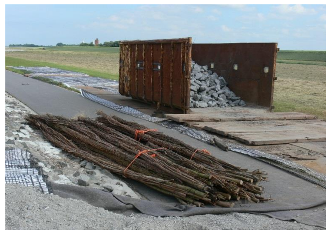
Abb. 12 Bühnenbau (Wasserbausteine auf Geotextil mit Faschinen-Rost aus Weiden-Bündeln)
