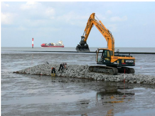
Abb. 12 Bühnenbau (Wasserbausteine auf Geotextil mit Faschinen-Rost aus Weiden-Bündeln)
